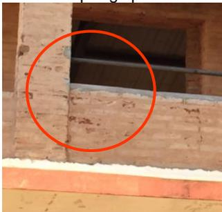
• **Observaciones:** Al producirse golpes de obra, como por ejemplo en este caso, la picar para macizar una baranda en el muro, se producen fisuras.
