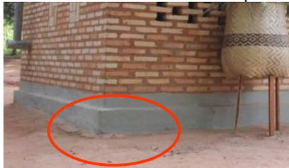
• **Observaciones:** El cimiento se ha realizado con suelo-cemento compactado con dosificaciones de 1:10. Los análisis realizados arrojan resistencia equivalente a otros materiales, mejorando su resistencia con el paso del tiempo.
