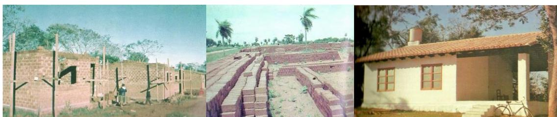
Foto 11 y Foto 12: Conjunto de 32 viviendas con bloques en suelo-cemento construidas por CIPAE con ayuda mutua en la comunidad de Koé Mbota Capiatá. Foto 13: Centro de Atención Primaria de Salud construida con el mismo sistema en Guazú Cua, Paraguari. Fuente: Ríos Cabrera.
