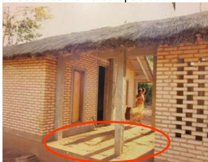
• **Observaciones:** Se han utilizado contrapisos y pisos de suelo-cemento compactados con dosificaciones de 1:10.
